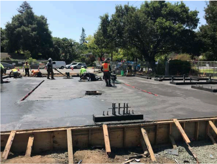
Mat Slab Pour Finish.
